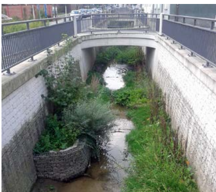
Deininghauser Bach, Castrop-Rauxel (nach Umbau)
